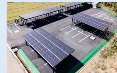
* 施工例 伊根町 (京都府与謝郡)
