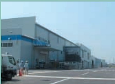
建設中の押出工場
