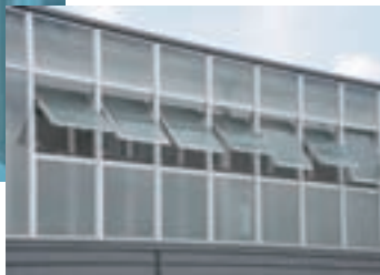
自然換気システム「NAV-Window-21」
