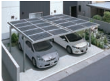
太陽光発電 システム 「ソーラスター」
