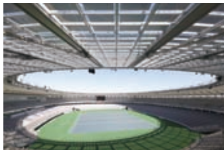
●太陽光発電システム 「三協立山ソーラー」
