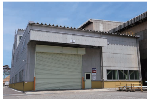
奈呉工場鋳造北工場増築棟内に設置されたスクラップ専用溶解炉 増築棟建屋外観（2026年6月稼働開始）
