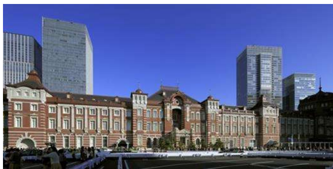
▲ 東京駅 丸の内駅舎復原
