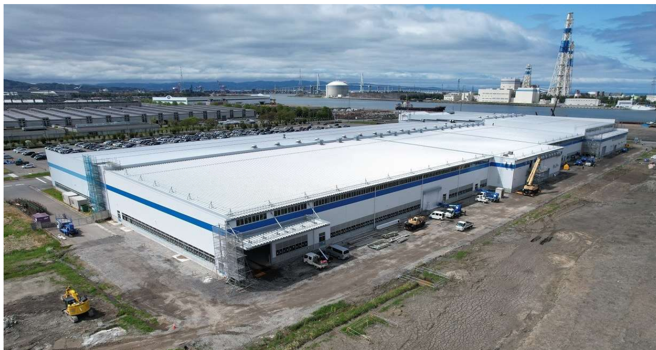
増築工事 進捗状況 (2025年4月時点)
