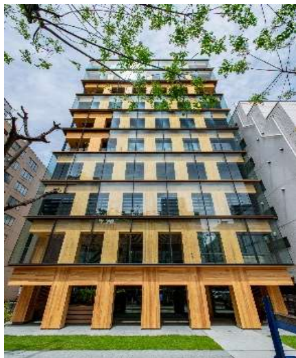
▲ Port Plus (大林組次世代型研修施設)
