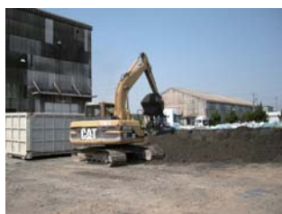
三協立山アルミ奈呉センター 土壌撤去工事
