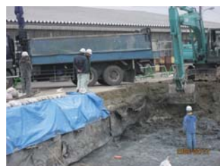
高岡工場土壌撤去工事
