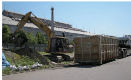
奈呉センター土壌撤去工事
