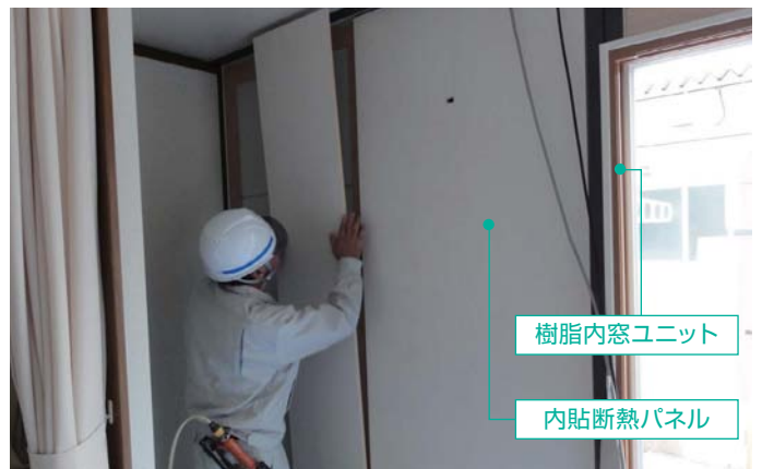
福島県の仮設住宅において「内貼断熱パネル・窓システム」を施工しているところ
