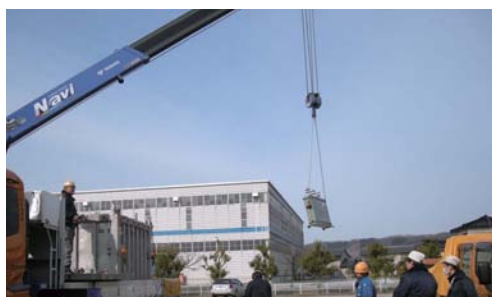
日本環境安全事業(株)へのPCB含有工作物搬出作業
