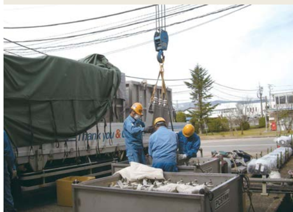
日本環境安全事業(株)へのPCB含有工作物搬出作業
