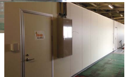
三協マテリアル高岡工場の空き建屋内に設置された植物工場
