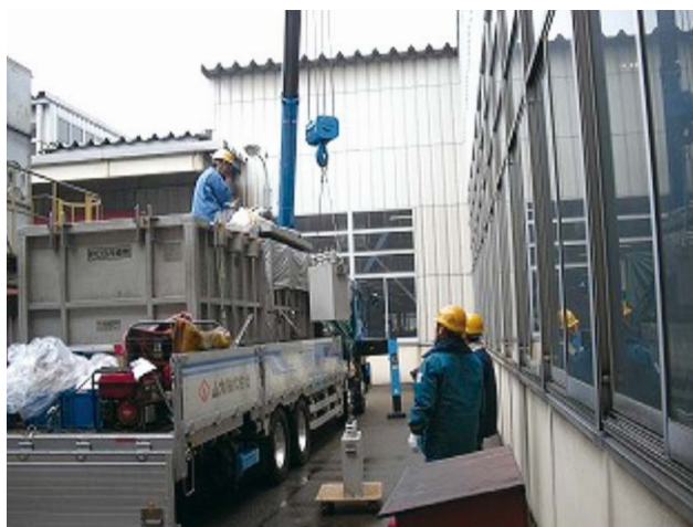
日本環境安全事業(株)へのPCB含有工作物搬出作業
