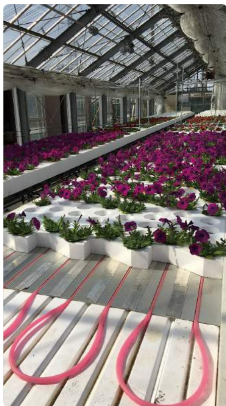
アルミ部材で温水(冷水)の熱を均一に伝える
